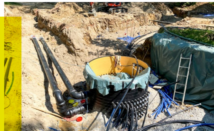
Bau des Erdwärmesondenfeldes im Quartier In der Rehre, Wettbergen.
